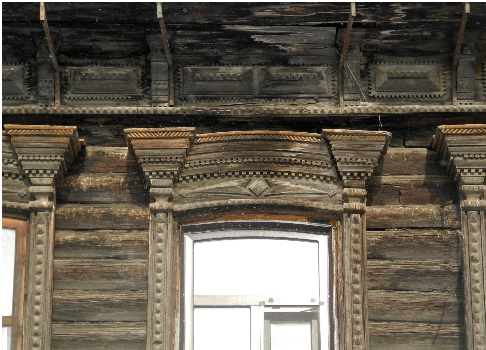
Фрагмент южного фасада
